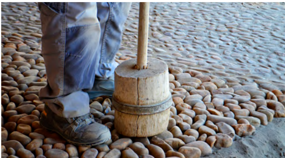
Proceso de realización de un empedrado en Guadalajara
