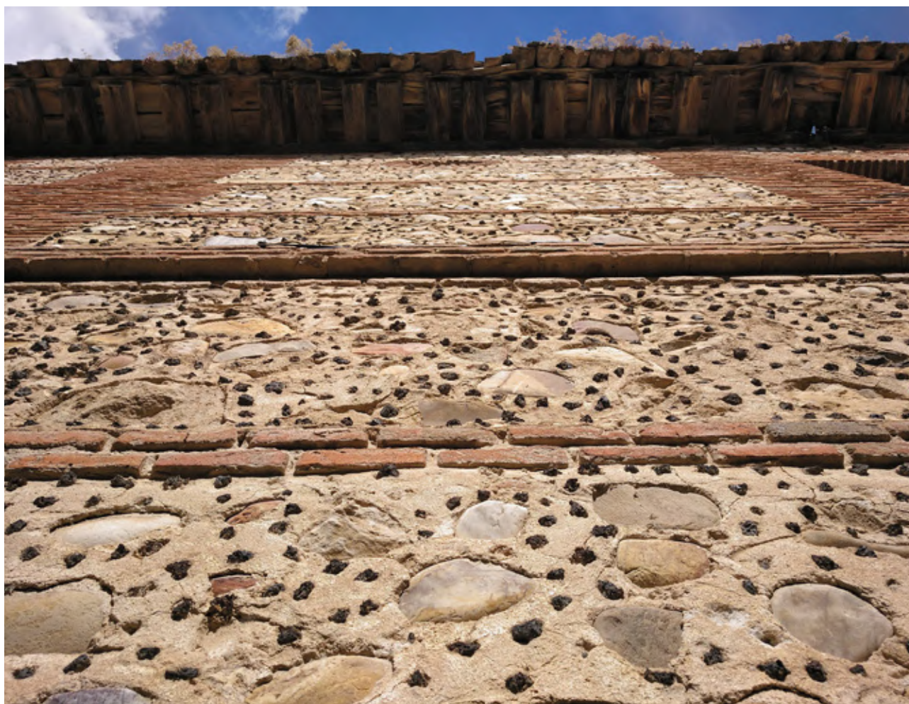
Detalle de un muro decorado con escorias en la Cartuja de Talamanca de Jarama, Madrid
