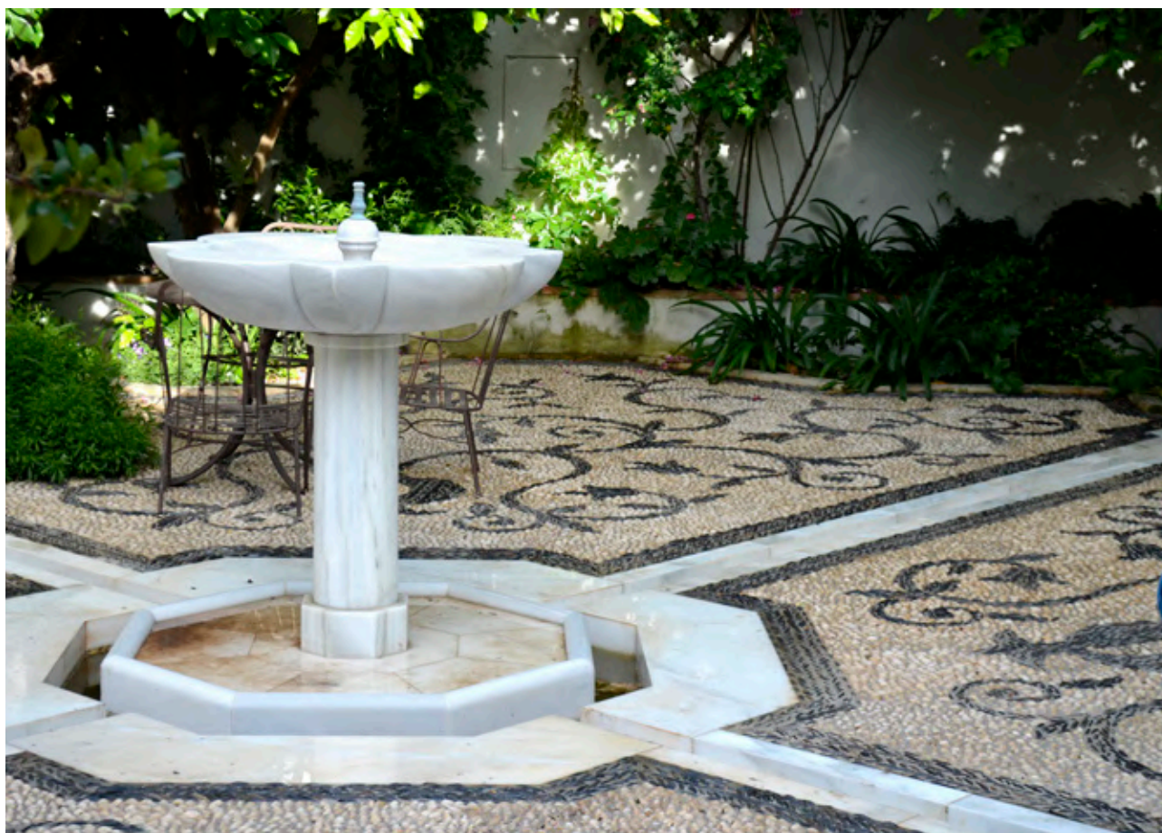
Empedrado de un patio que integra una fuente central y canales que lo dividen en cuartos
