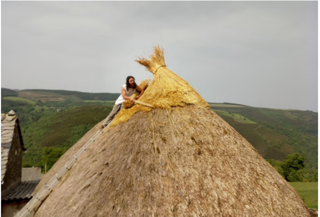
Reparación de una cumbre dañada
