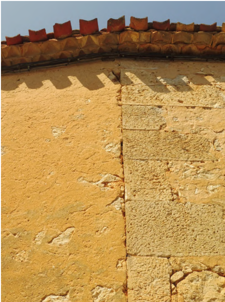
1. Encuentro entre dos muros en una casa en Caleruega, Burgos
