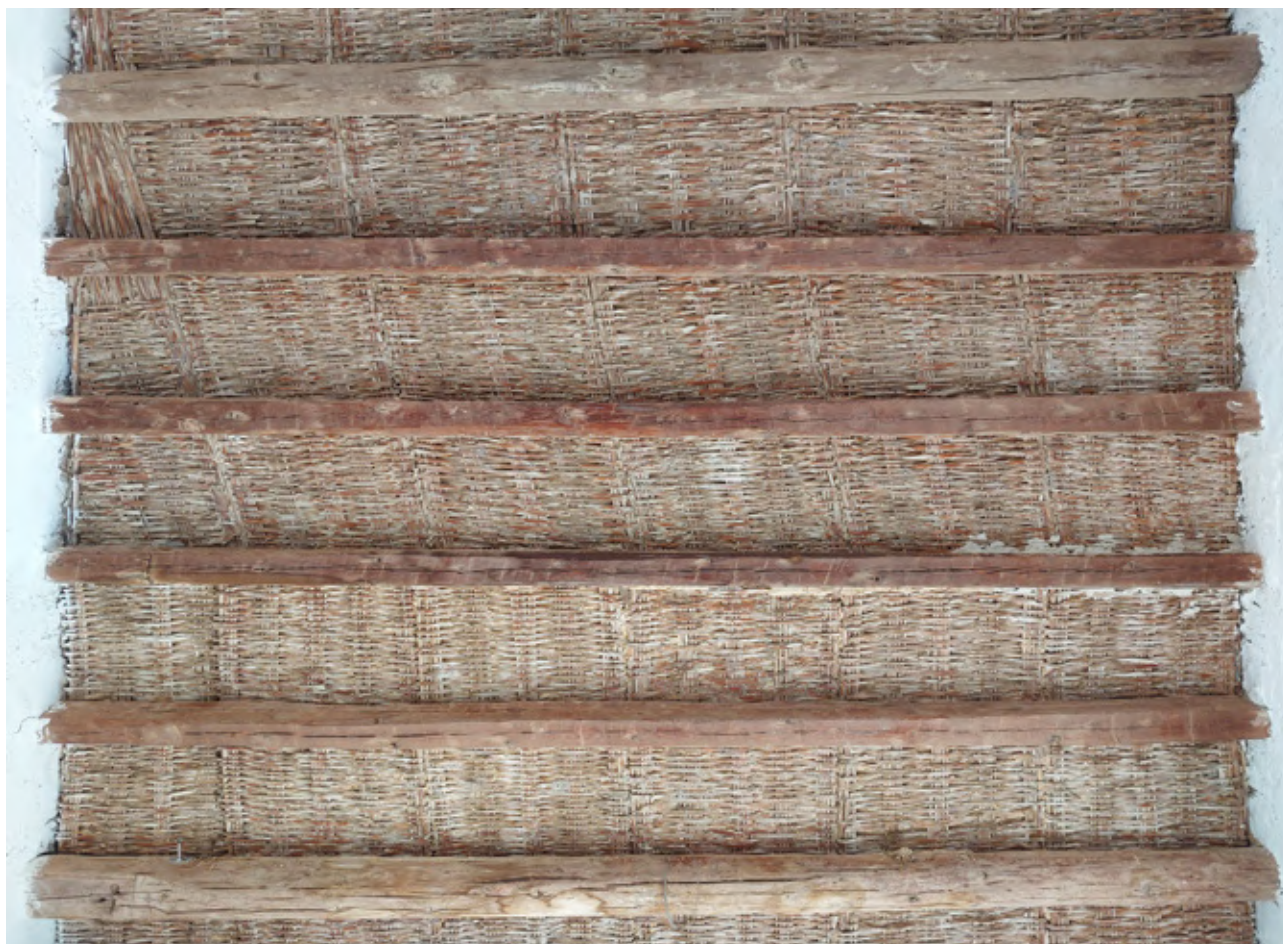
Forjado tradicional de cañizo en Chodes, Zaragoza
