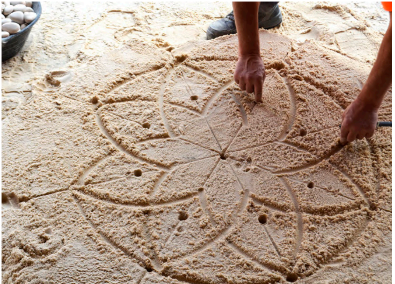
Trazado geométrico del empedrado en la base de arena sobre la que se ejecutará
