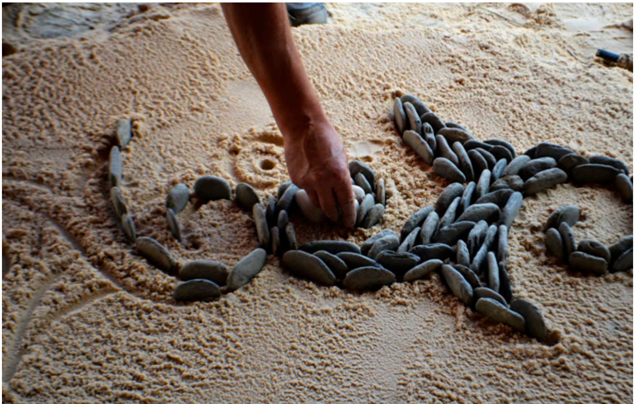
Colocación en espiga de la piedra de pizarra
