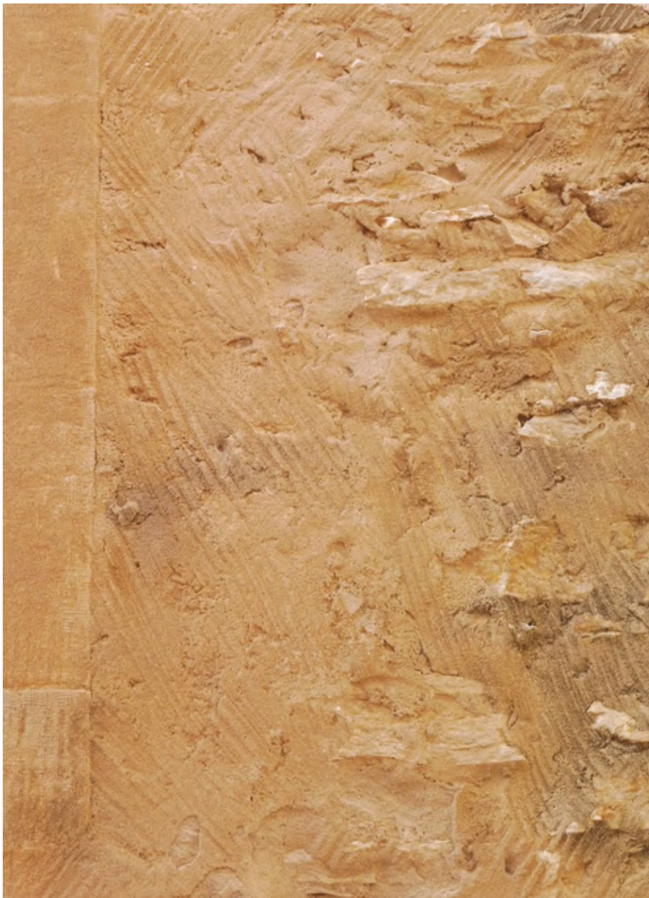
Revestimiento de un muro en Begur, Gerona
