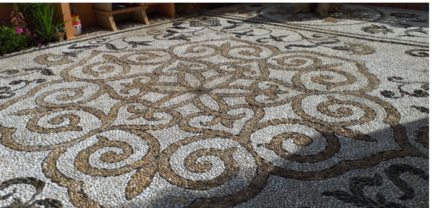
Empedrado realizado con tres tipos de piedra
