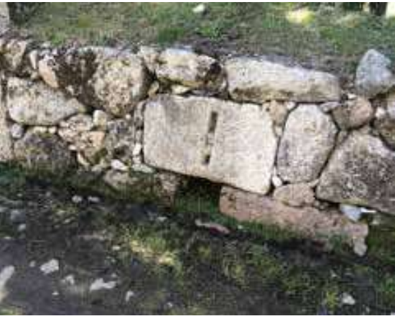
Opening on the structure for the passing of the distribution canal network. | Abertura na estrutura para a passagem da rede de canais de distribuição. | Abertura en la estructura para el paso de la red de canales de distribución.
