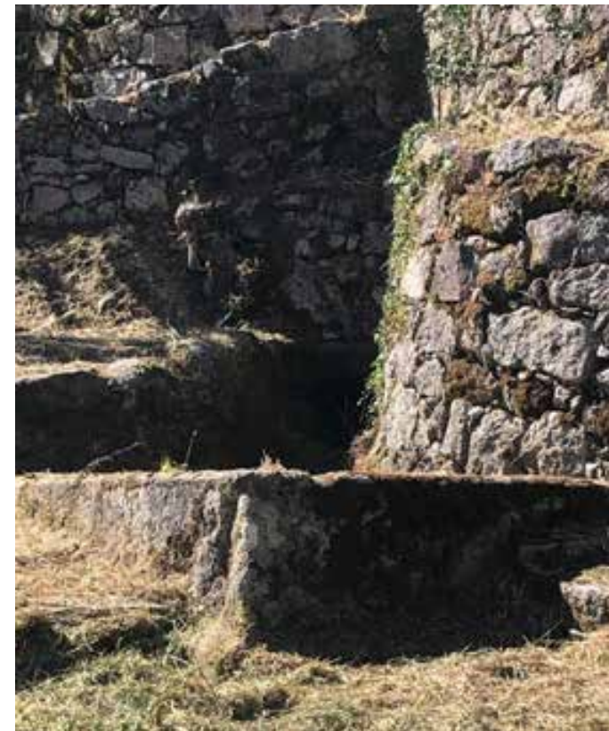
Cistern to ensure the availability of water. | Cisterna para garantir a disponibilidade de água. | Cisterna para garantizar la disponibilidad de agua.
