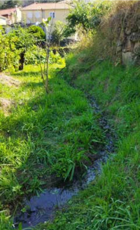
Distribution canal done through dry stone techniques. | Canal de distribuição construído com técnicas de pedra seca. | Canal de distribución realizado con técnicas de piedra seca.
