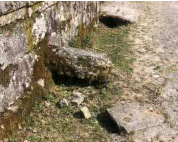
Opening gates in the distribution canal network. | Portas de abertura na rede de canais de distribuição. | Compuertas de apertura en la red de canales de distribución.
