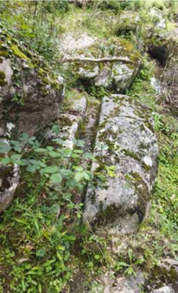
Distribution canal done through cutting the existing stone. | Canal de distribuição feito através do corte da pedra existente. | Canal de distribución realizado mediante el corte de la piedra existente.
