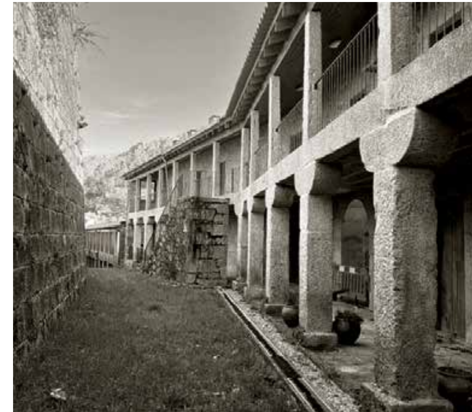
Granite gallery structure and balconies in the rear outdoor area of the Pilgrims' Quarters | Estrutura granítica da galeria e varandas da zona exterior posterior do Quartel de Peregrinos | Estructura de galería y balcones de granito en la parte trasera exterior del Cuartel de Peregrinos
