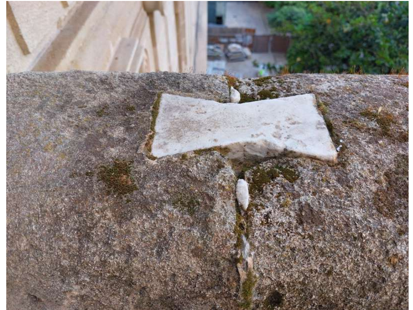
Unión de cantería en un parapeto sobre las cubiertas de la catedral de Sevilla
