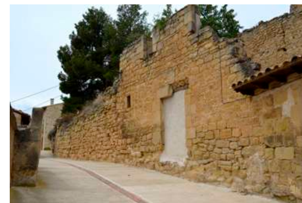
Exterior e interior del solar destinado al nuevo edificio
