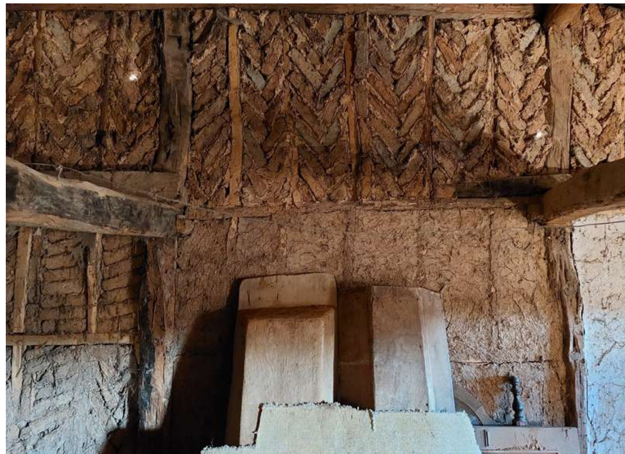
Muro entramado con relleno de adobe en espiga en Encinas, Segovia
