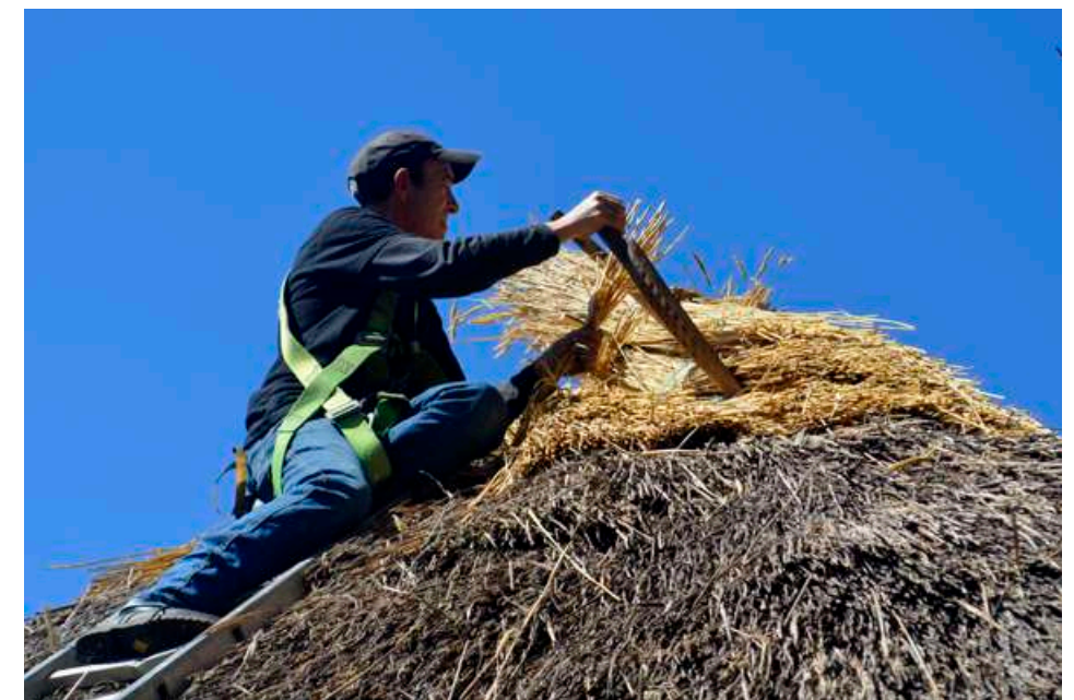
Renovación de la cubierta de un hórreo
