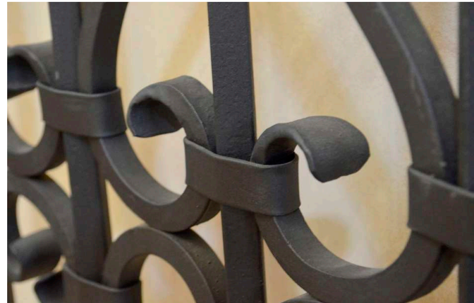
Detalle de una unión de forja tradicional
