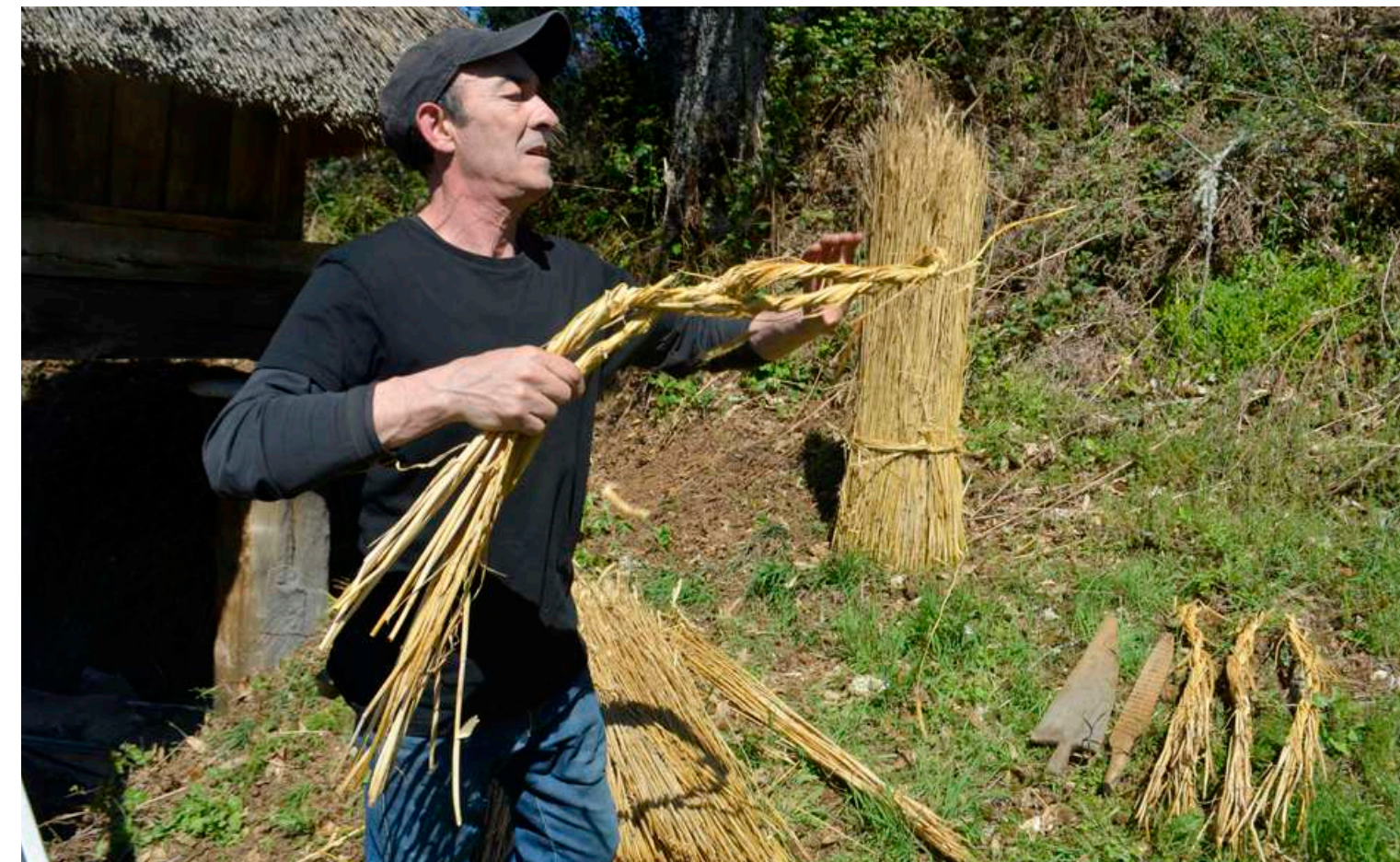
Manuel Monteserín trenzando brincallos para atar los mollos a la estructura
