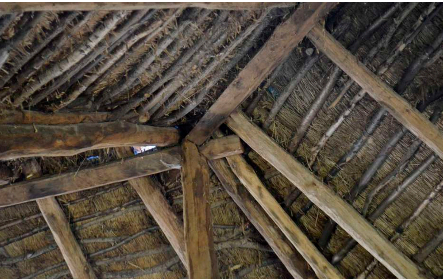
Interior de la cubierta de la Palloza de Chis en Balboa
