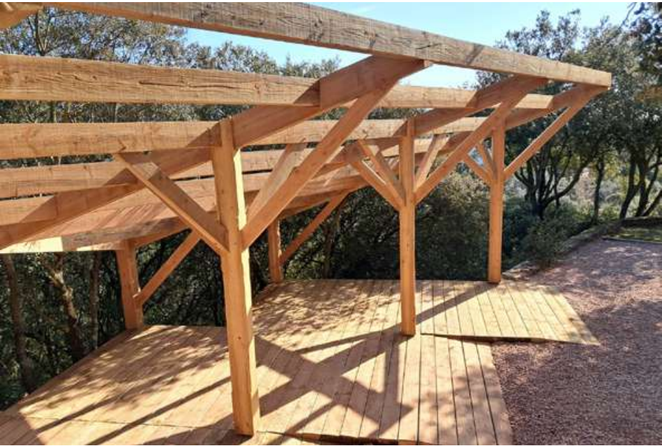
1. Estructuras de madera realizadas en Castellón de Ampurias, en Gerona, y El Brull, en Barcelona 2. Levantamiento, detalle y proceso de construcción de una vivienda en Avinyonet del Penedès, in the province of Barcelona
