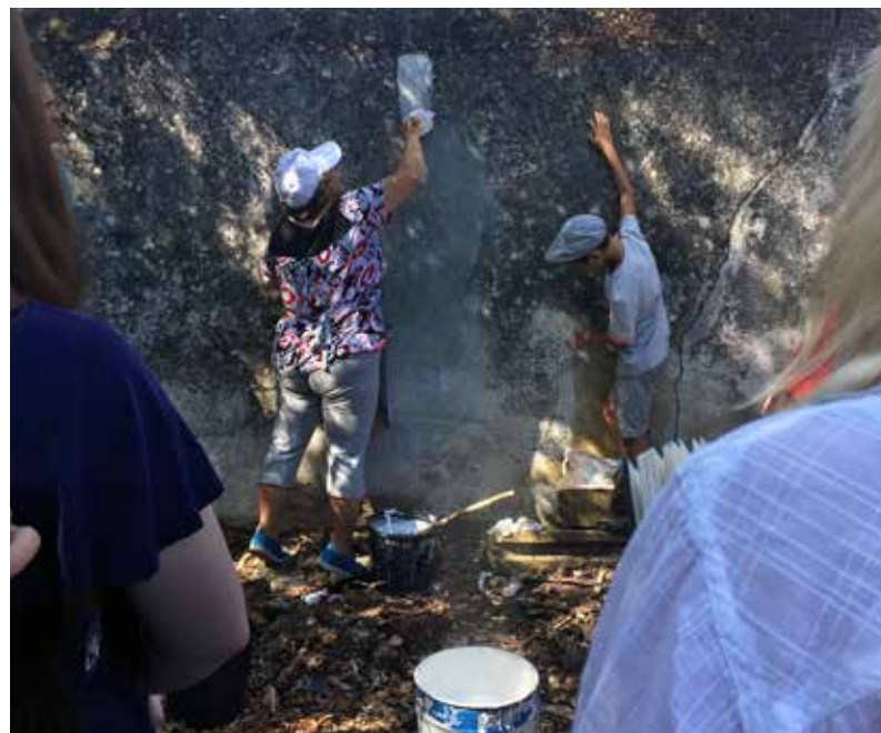
Limewash demonstration by Maria Filomena Gaspar Picado Demonstração de pintura com cal com Maria Filomena Gaspar Picado Demostración de aplicación de encalados por Maria Filomena Gaspar Picado
