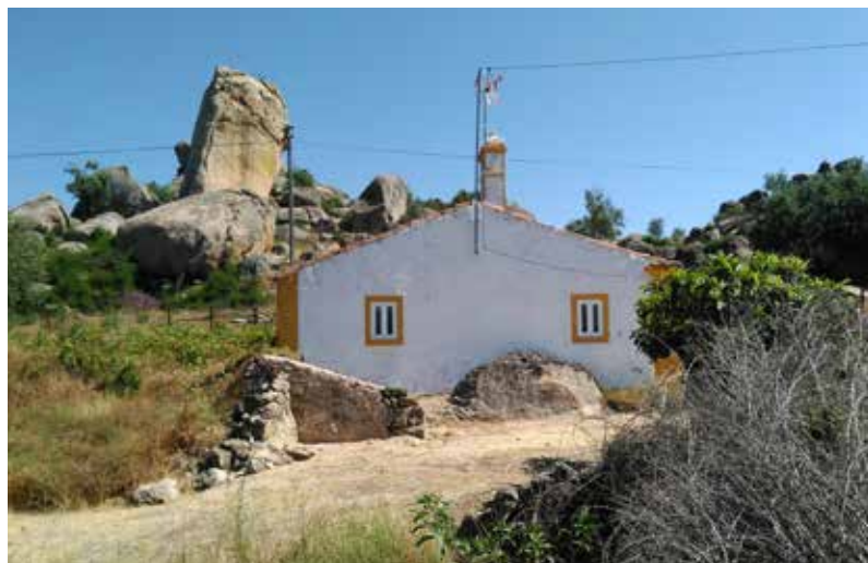
Railway gate building with paintings dramatically depicting the departure of the railway activity from Beirã Casa do ferrocarril com pinturas que representam dramaticamente o fim da actividade ferroviária da Beirã Caseta del ferrocarril con pinturas que representan dramaticamente el cese de la actividad ferroviaria de Beirã
