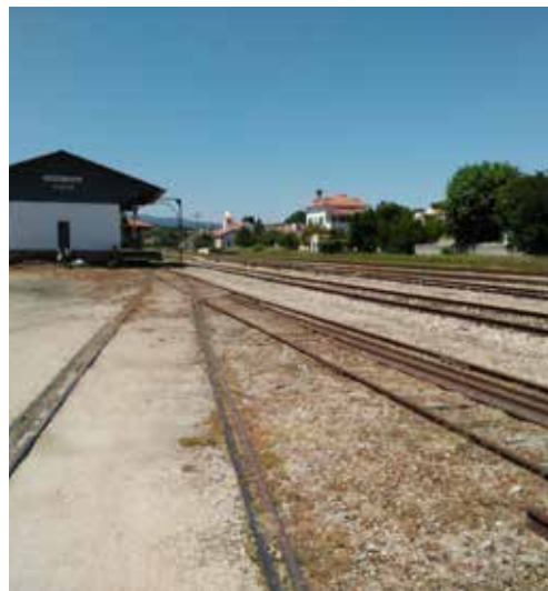
Vista das infra-estruturas da zona da estação ferroviária Vista da ferrovia e do armazém Vista de las vías del ferrocarril y el almacén
