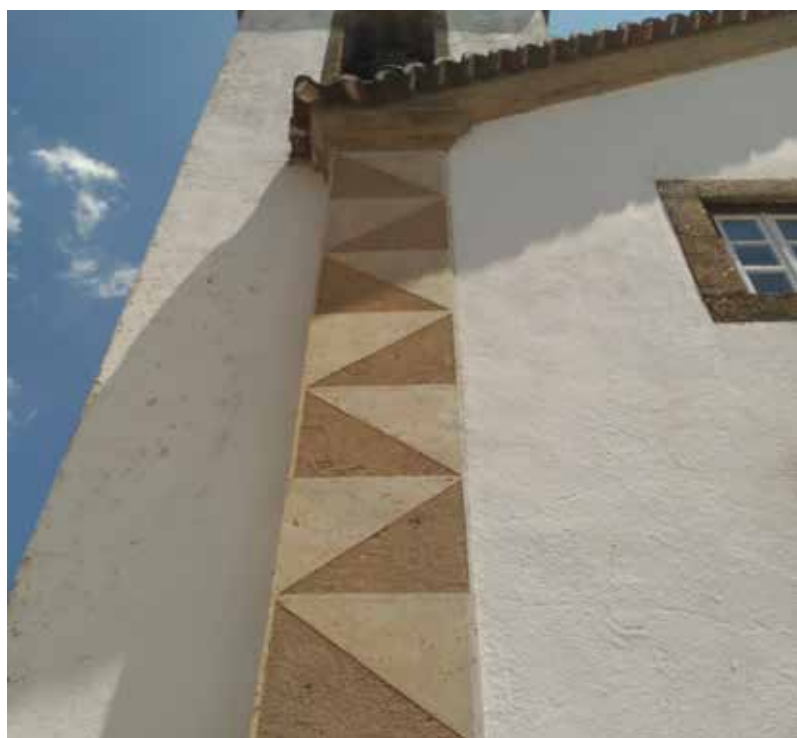
Sgraffito finishings in Marvão Esgrafiados em Marvão Esgrafiados em Marvão
