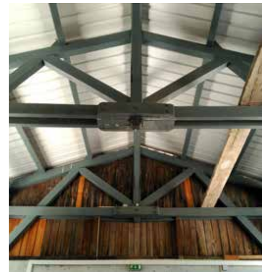
Wooden structure of the warehouse Estrutura do armazém, em madeira Estructura de madera del almacén
