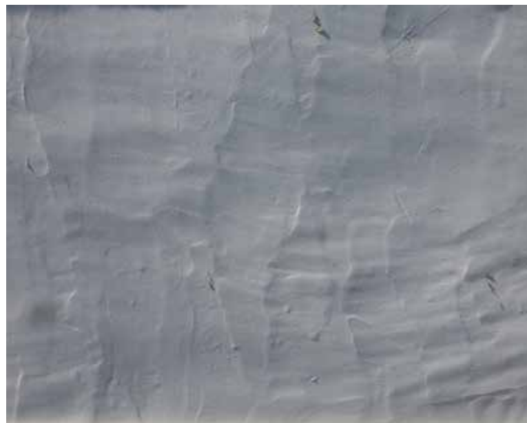
Texture of the lime washed walls of a new restaurant by José Baganha in Terena Textura das paredes caiadas de branco de um novo restaurante projetado por José Baganha em Terena Textura de las paredes encaladas de un nuevo restaurante diseñado por José Baganha en Terena
