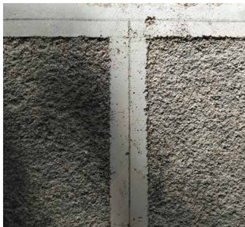
Sgraffito finishings in Castelo de Vide Esgrafiados em Castelo de Vide Esgrafiados em Castelo de Vide
