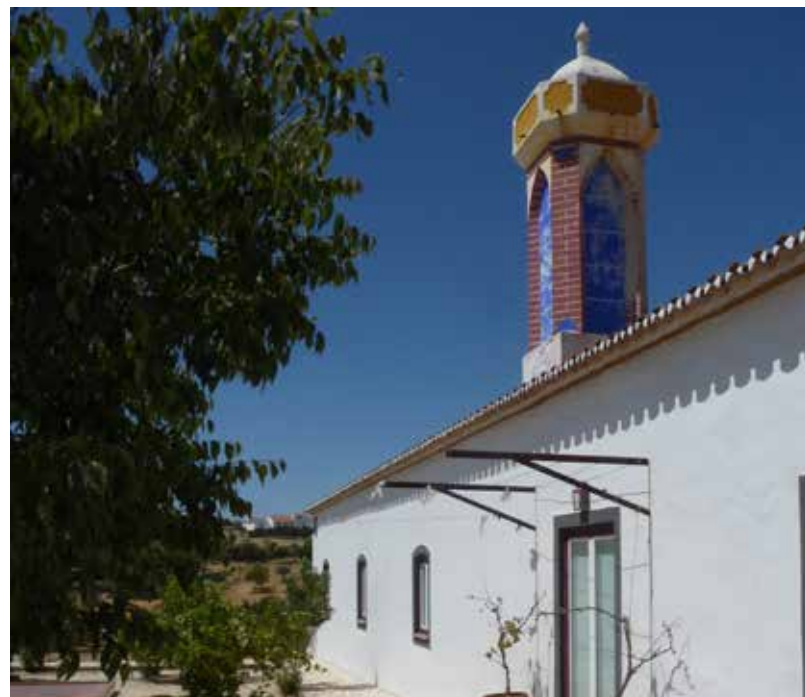
Chimney in the Monte da Quinta, Alandroal Chaminé no Monte da Quinta, Alandroal Chimenea en el Monte da Quinta, Alandroal
