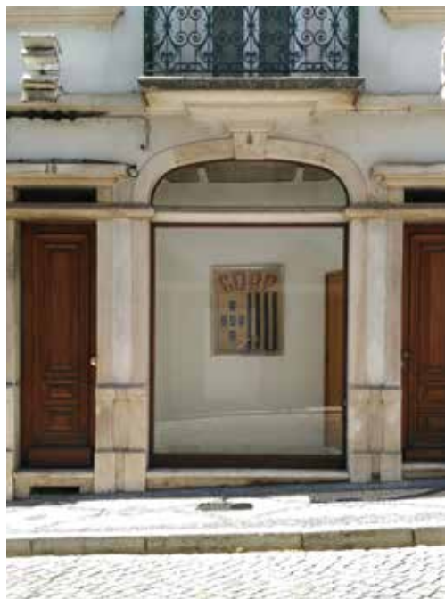
Urban house front in Évora Frente de casa do tipo urbano em Évora Alzado de casa de tipo urbano em Évora
