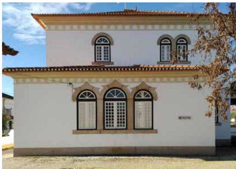
Northeast Façade of the Former Station Restaurant, Beirã Fachada nordeste do antigo restaurante da Estação, Beirã Fachada noreste del antiguo restaurante de la Estación, Beirã
