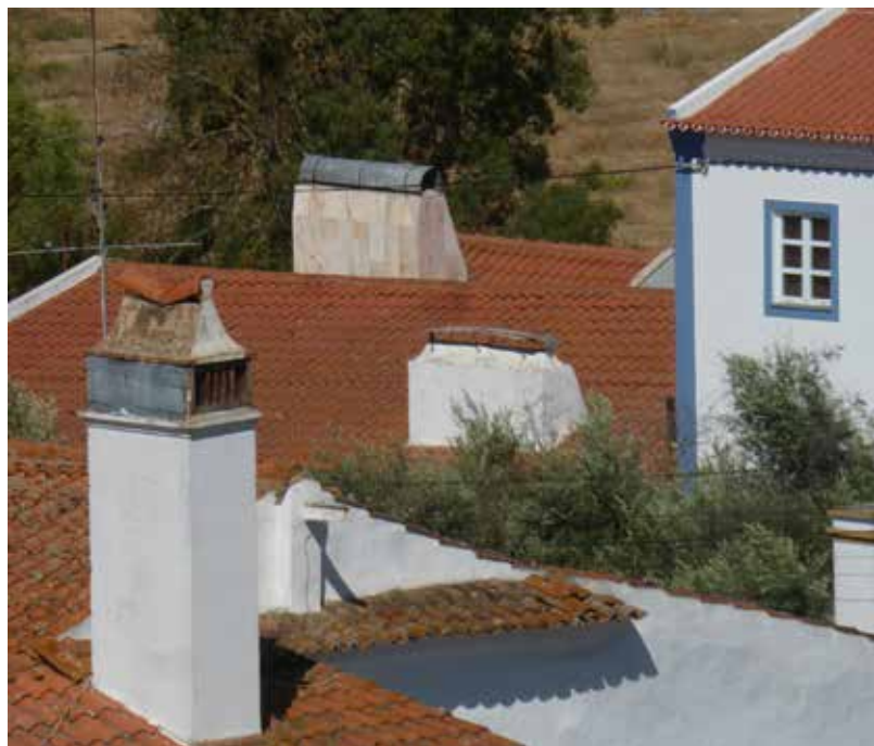
Chimneys in Terena Chaminés em Terena Chimeneas en Terena
