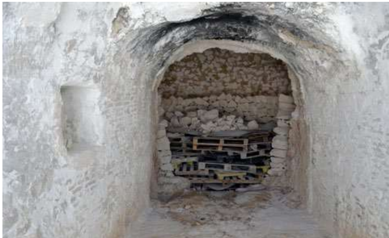
Boca de un horno de cal tradicional
