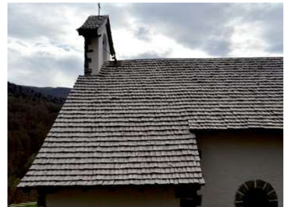
Cubierta de tablilla de madera de haya de la ermita de la Virgen de las Nieves
