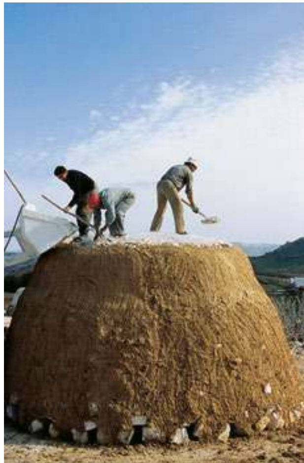
2. Reparación interior del vaso de un horno de cal tradicional
