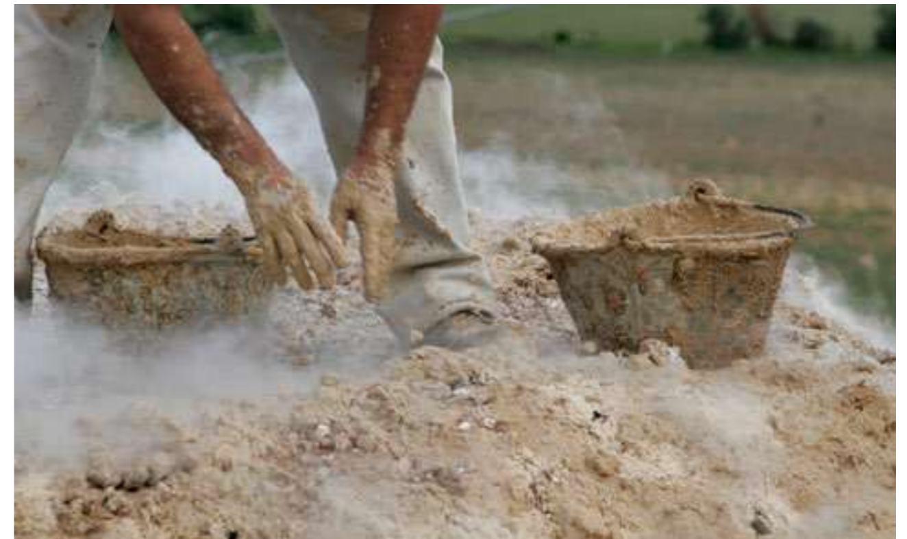
Trabajos de reparación de un horno de cal tradicional
