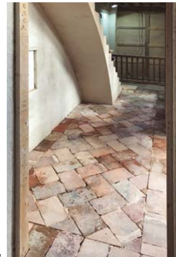
1. Solado de baldosas cerámicas tradicionales y escalera tabicada 2. Tejado tradicional en el Convento de Santo Domingo el Antiguo, Toledo
