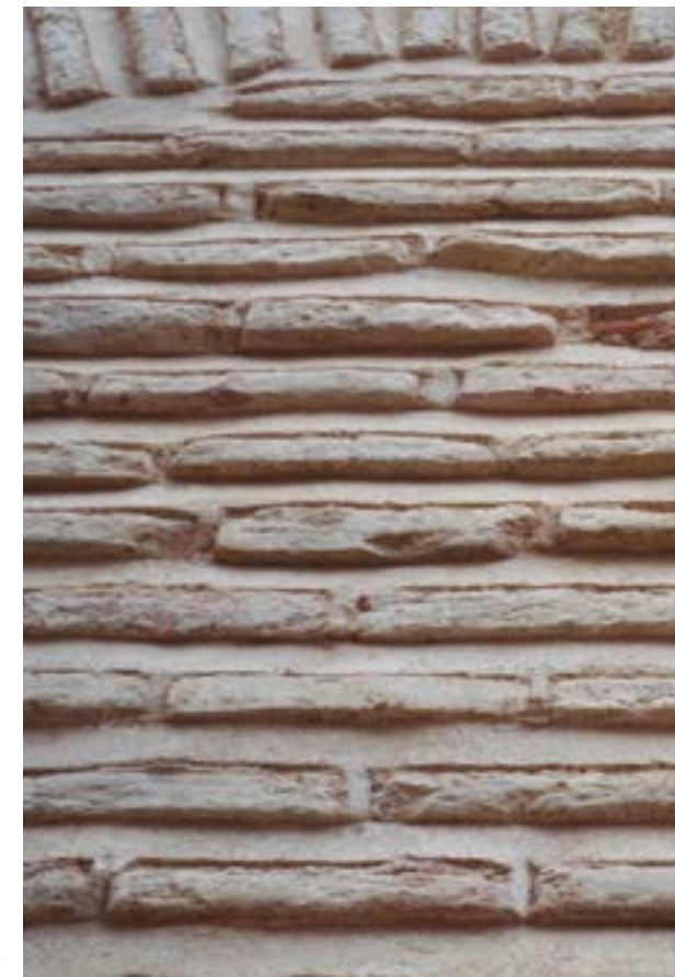
2. Aparejo mixto de ladrillo y mampostería de piedra decorado con escorias
