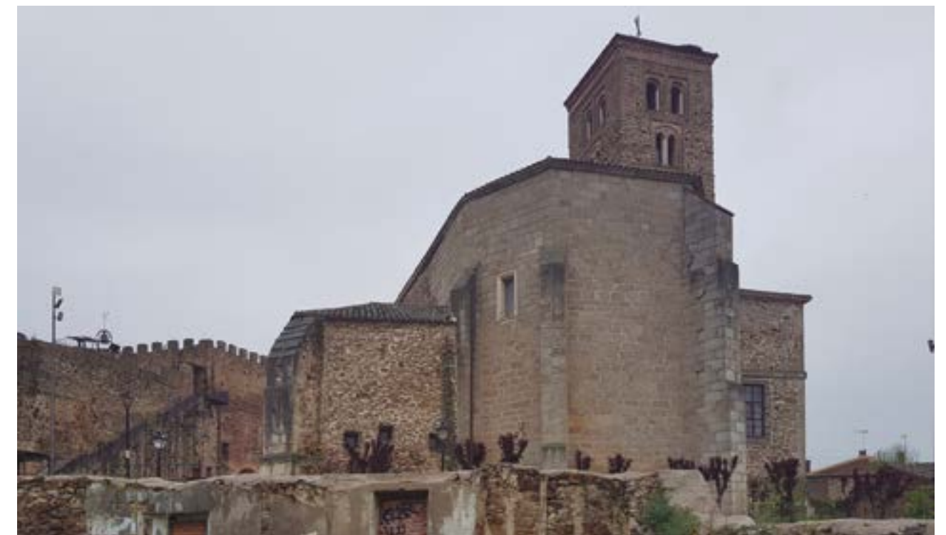
Interior de la parcela Plaza del Gato, 3, junto a la Iglesia de Santa María
