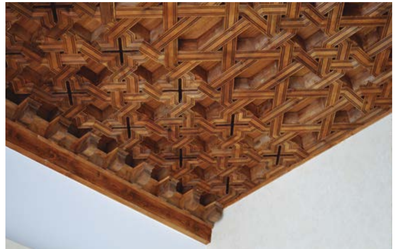
1. Colocación de los taujeles para formar motivos geométricos 2. Alfarje de nueva construcción en la calle La Rúa, 32, en León
