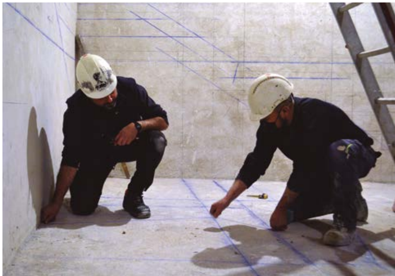
Proceso de replanteo de una escalera en obra
