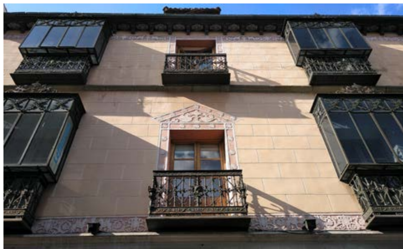
Fachada en Segovia
