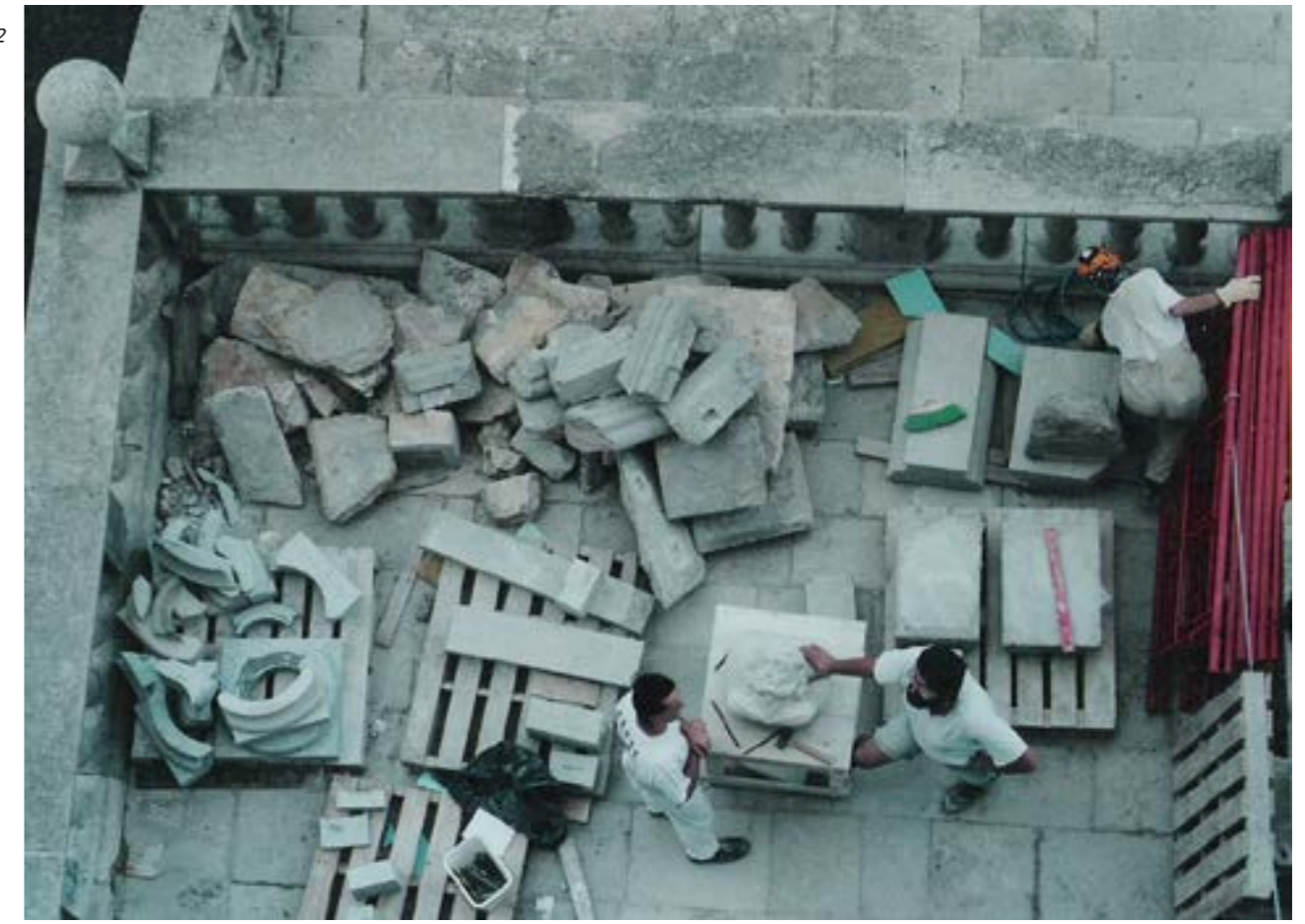
1. Detalle de la fachada barroca de la Catedral de Gerona, tras su restauración 2. Taller de cantería a pie de obra en la restauración de la Catedral de Gerona
