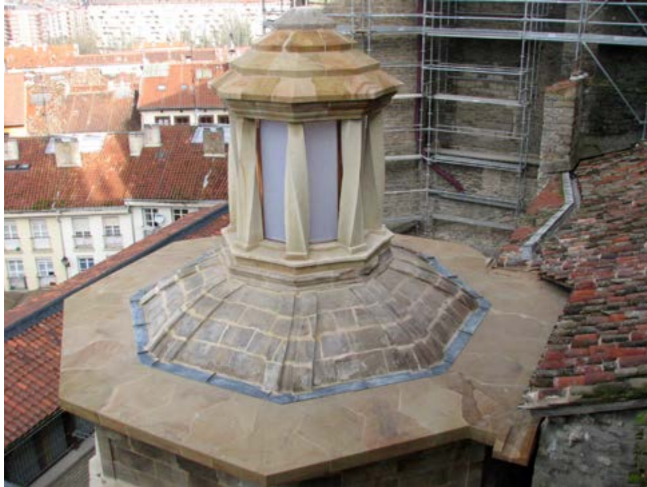
1 y 2. Nuevas cubierta pétrea y linterna de la Capilla del Cristo de la Catedral de Vitoria-Gasteiz
