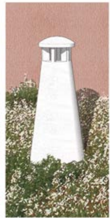
Chimenea de ventilación tradicional con forma troncocónica de fibrosa de ladrillo esmaltado
