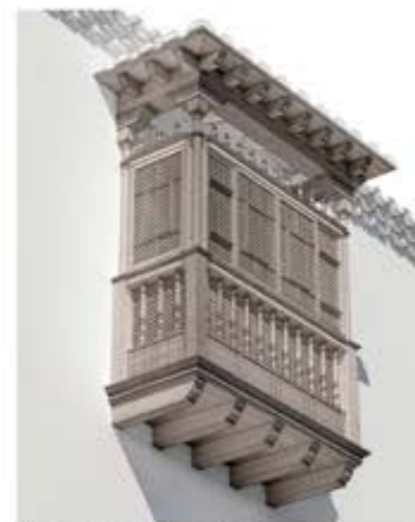
Perpectiva inferior del alero en la fachada sur
