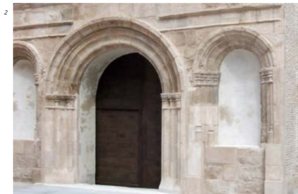
1 y 2. Portada de San Julián de la fachada sur de la Colegiata de San Antolín de Medina del Campo, Valladolid, antes y después de su restauración
