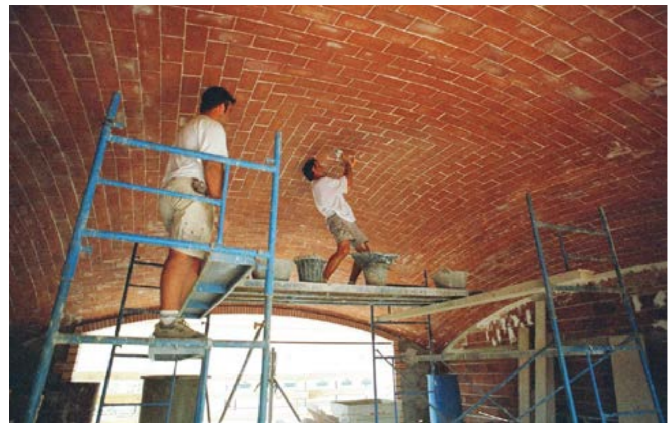
1. Construcción de una bóveda tabicada por Jordi Domenech 2. Capilla de la Música realizada por el maestro albañil Jesús Adeva (aplicación de los revestimientos de cal) y por el artista Frederik Takkenberg (pintura de los frescos)
