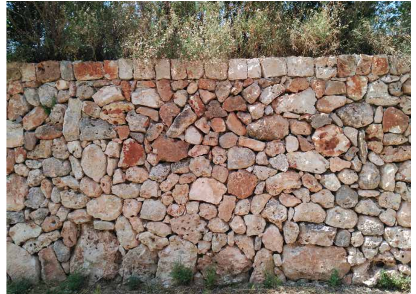
Muro de piedra en seco, Ruberts, Mallorca
