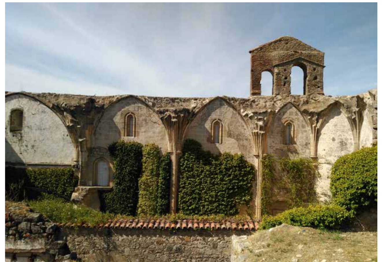
Ruinas de la Iglesia del Convento de la Coria
