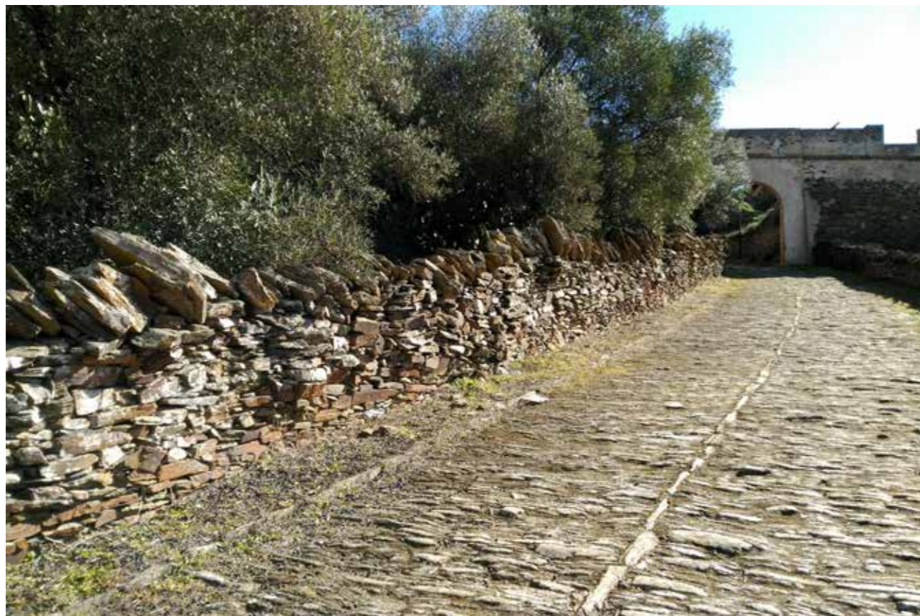
Muros de piedra en seco y empedrados en el ascenso a Alcántara, Cáceres
