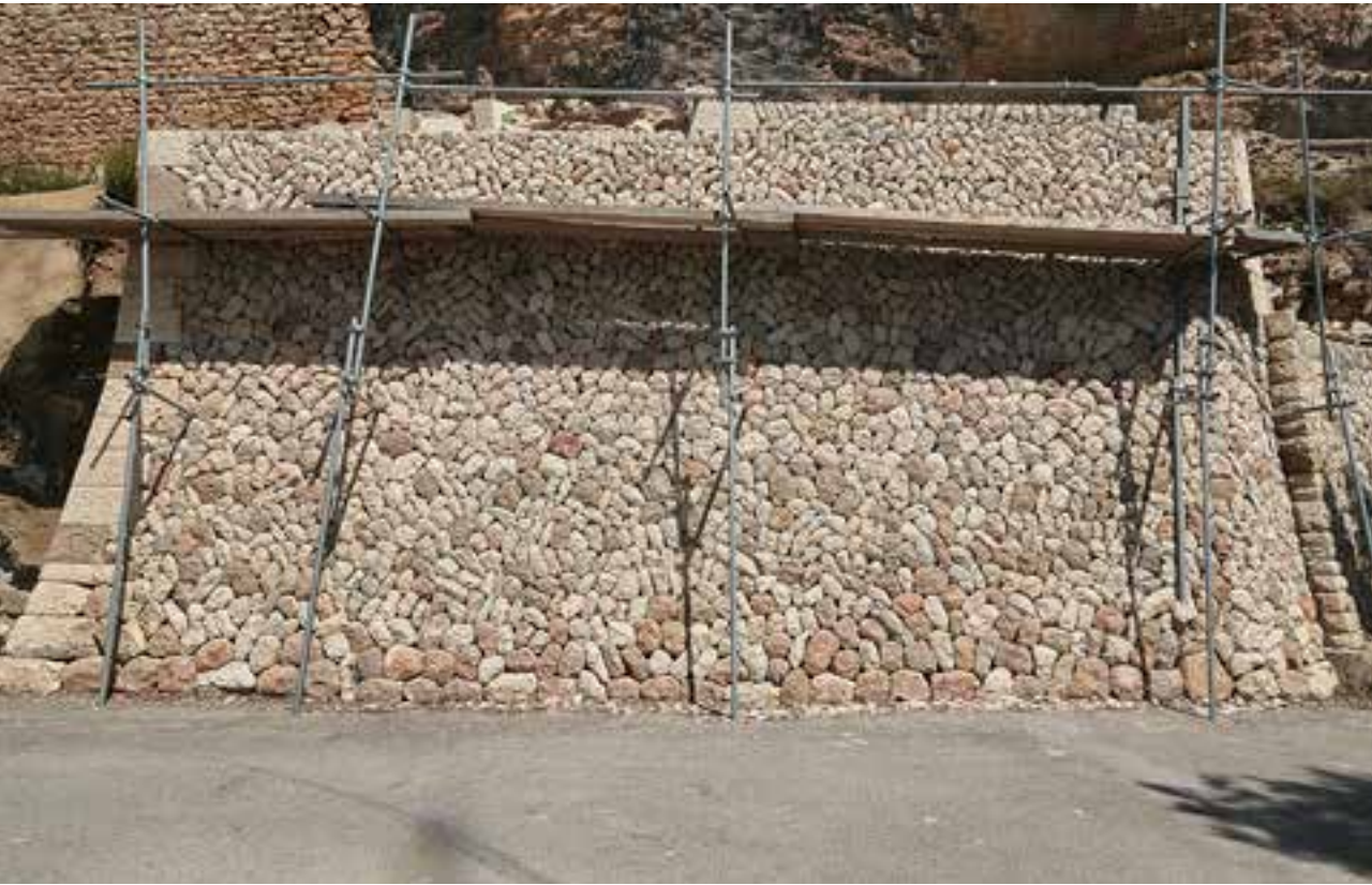
2. Cara interior de un muro de mampostería y mortero de cal 3. Cara exterior de un muro de mampostería y mortero de cal
