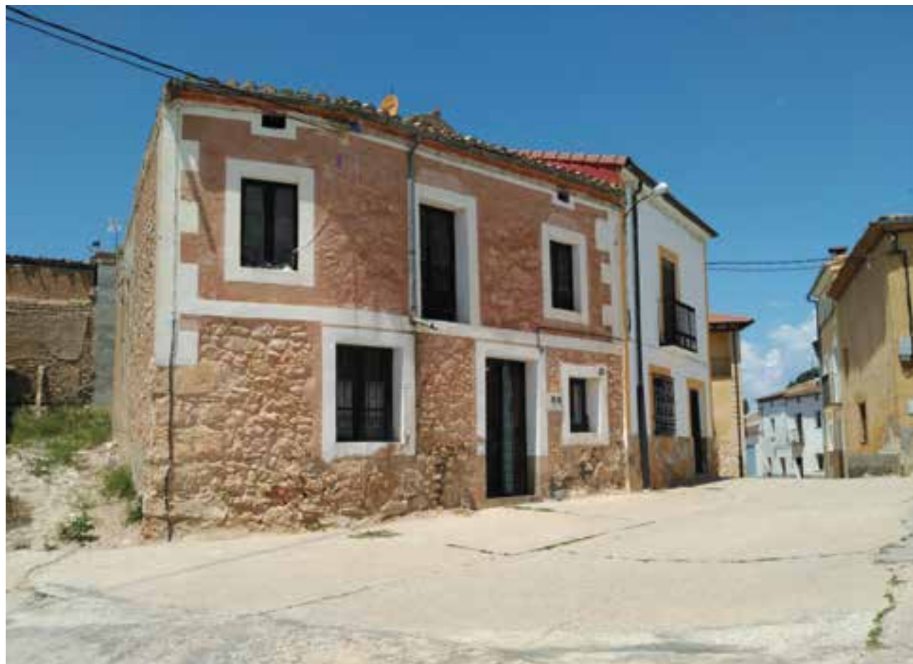
Construcción tradicional en Vildé, Soria
