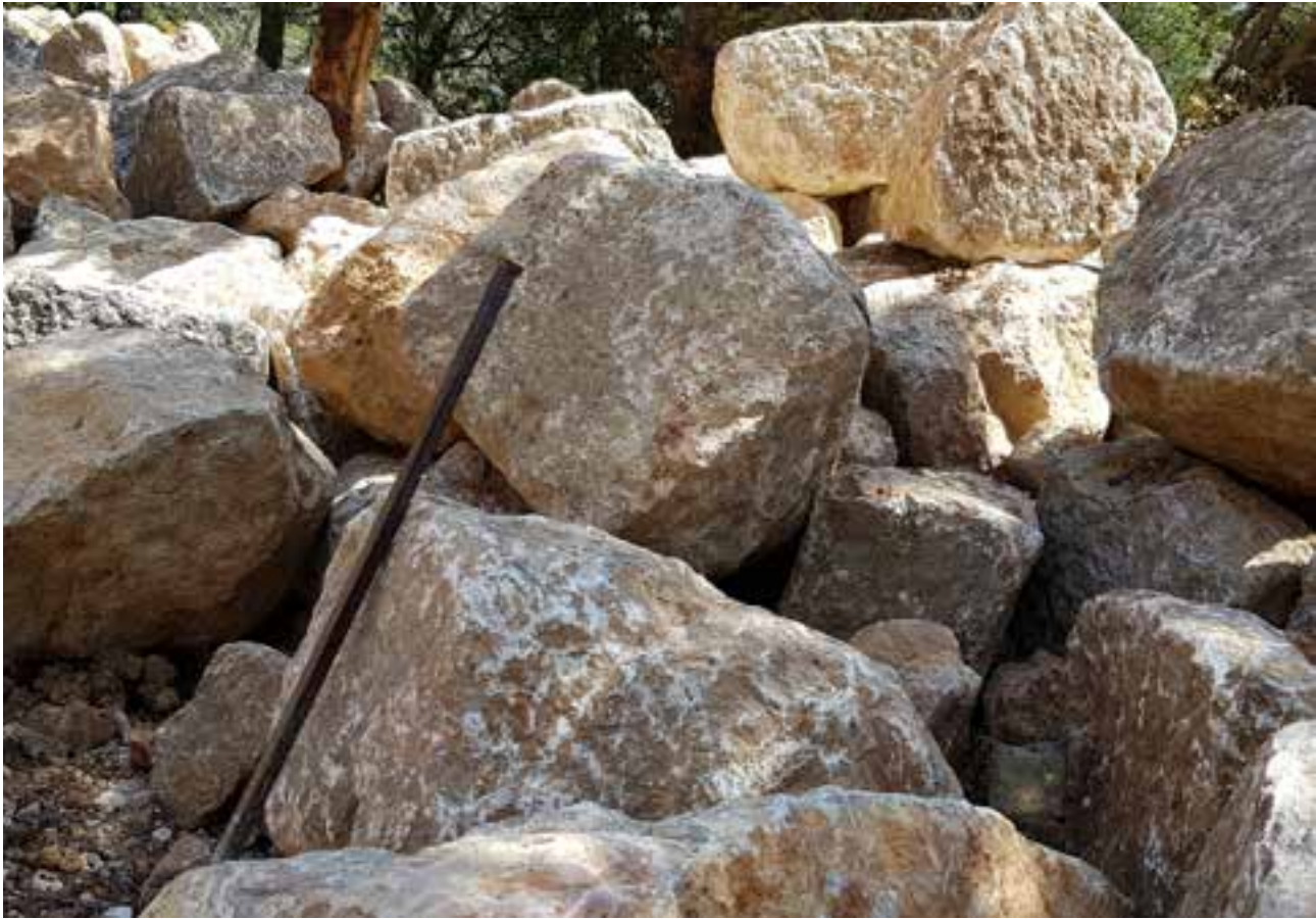
Piedras recuperadas del derrumbe del muro, listas para volver a usarse en su reconstrucción
