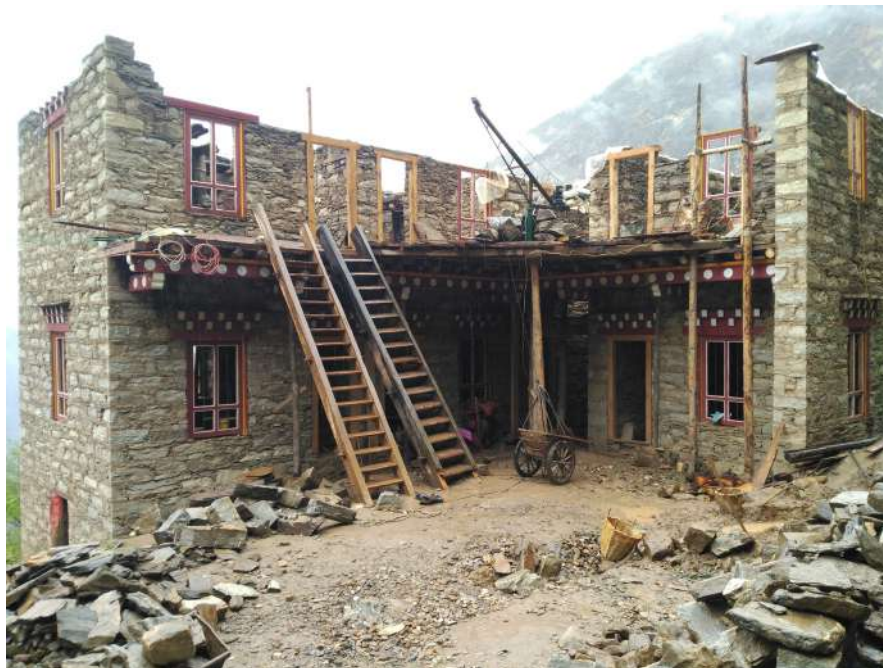
Nueva Arquitectura tradicional en construcción en Chonglu, Sichuan, China Nova Arquitectura tradicional em construção em Chonglu, Sichuan, China New Traditional architecture under construction in Chonglu, Sichuan, China
