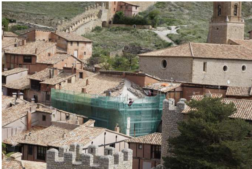
Restauración de la Casa de la Comunidad, Albarracín Restauração da Casa da Comunidade, Albarracín Restoration works of the Community House, Albarracín
