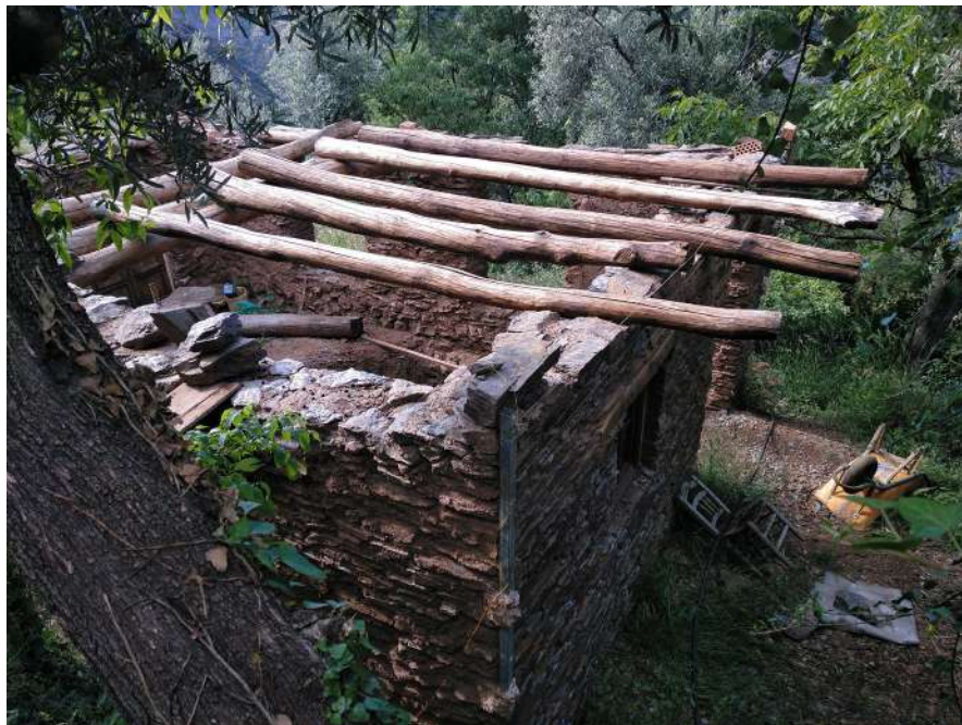
Nueva Arquitectura tradicional en construcción en Atalbéitar, Granada Nova Arquitectura tradicional em construção em Atalbéitar, Granada New Traditional architecture under construction in Atalbéitar, Granada
