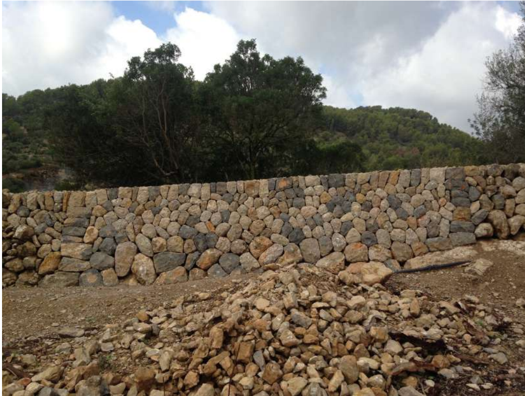
Pared seca de doble cara, tradicionalmente usada en Mallorca para delimitar parcelas y fincas agrícolas, restaurada por Lluç Mir Anguera Pared de pedra solta de duas faces, tradicionalmente utilizada em Maiorca para delimitar lotes de terra de cultivo, restaurada por Lluç Mir Anguera Double-sided dry-stone wall, traditionally used in Majorca to demarcate plots or farm land, restored by Lluç Mir Anguera
