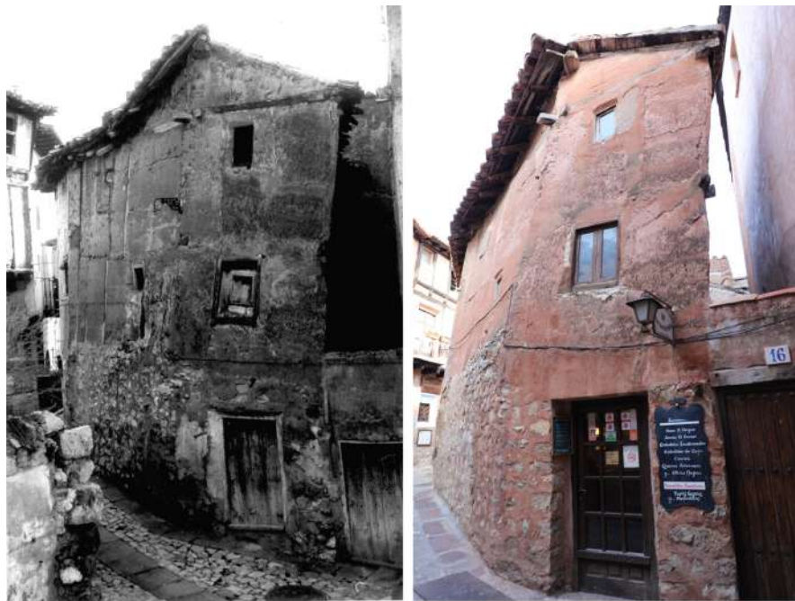
Casa de la calle del Chorro de Albarracín antes y después de su restauración Casa na calle del Chorro de Albarracín antes e depois da restauração House in the calle del Chorro of Albarracín before and after its restoration
