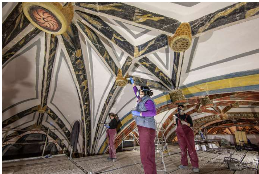
Restauración de las bóvedas de la Catedral del Salvador de Albarracín Restauração das abóbadas da Catedral do Salvador em Albarracín Restoration works of vaults of the Cathedral of the Saviour in Albarracín
