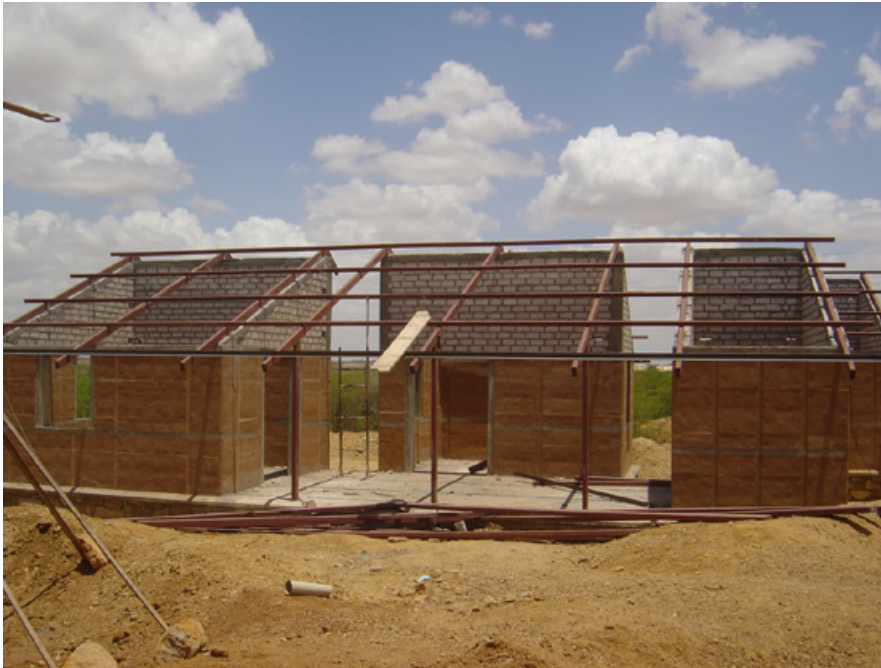
Construcción de un módulo en el Parque de los Oficios, Kutch, India Construção de um módulo no Crafts Park, Kutch, India Construction of a module in the Crafts Park, Kutch, India
