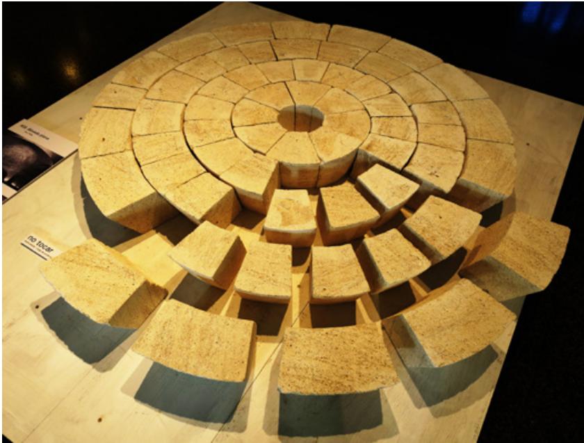
Bóveda plana. Trabajo realizado en el Taller de Cantería de la ETSAM Abóbada plana. Trabalho feito no Workshop de Cantaria da ETSAM Flat vault. Work done at the ETSAM Stonemasonry Workshop
