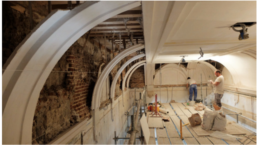
Reconstrucción de una bóveda de yeso Reconstrução de uma abóbada de gesso Reconstruction of a plaster vault
