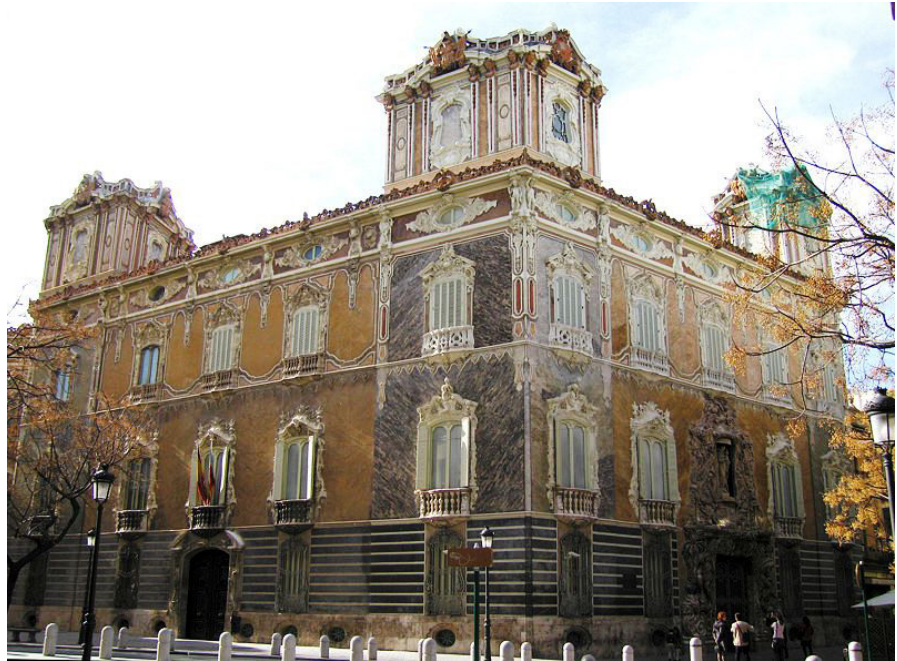
Fachada revestida con yeso, Valencia Fachada revestida com gesso, Valencia Gypsum plaster rendered façade, Valencia
