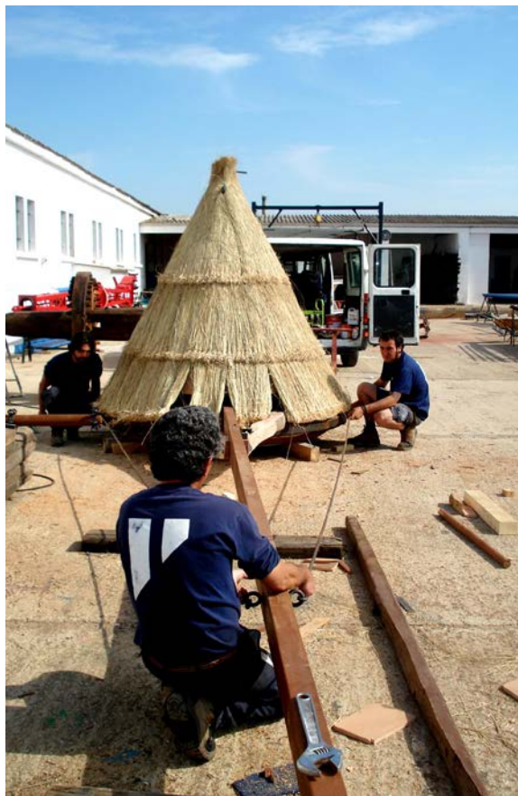
Premontaje del chapitel del molino de viento harinero de la finca de Son Gornals (Porreres)
