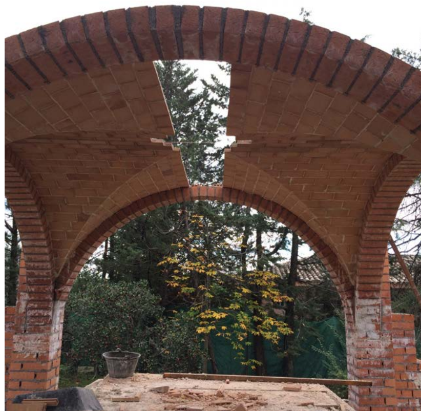
Proceso de construcción de una bóveda tabicada de arista al aire
