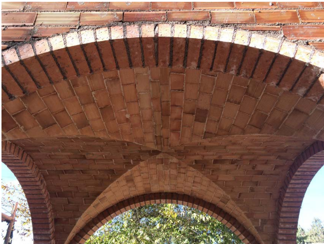
Proceso de construcción de una bóveda tabicada de arista al aire
