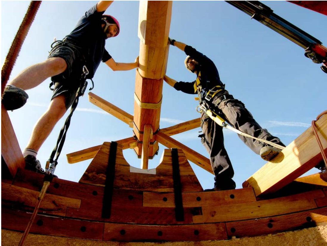
Montaje de la maquinaria del molino de viento harinero de Can Nofre (Montuïri)
