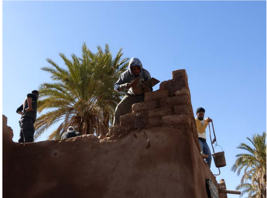
Restauración de la puerta de acceso al ksar de Ouled Mhia (Zagora, Marruecos) por el equipo de Terrachidia
