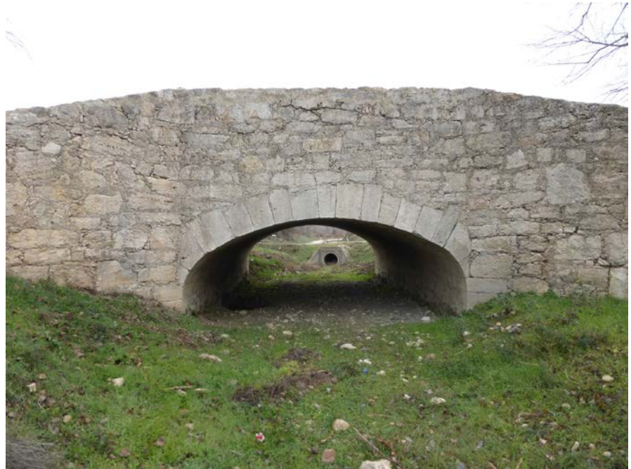
Primer acueducto del Canal de Cabarrús tras su restauración con técnicas tradicionales, Torremocha de Jarama (Madrid)
