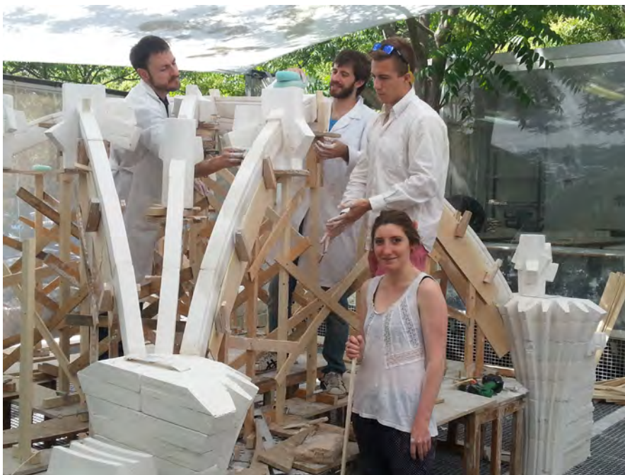
Construyendo una bóveda en el taller de construcción gótica de Madrid
