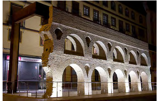
Restauración reciente en la que se han ensañado introduciendo en el "specus" una innecesaria estructura metálica
