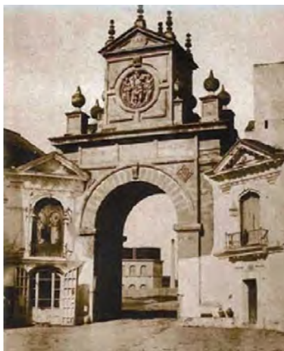
Puerta Real antes de su derribo con capillas adosadas
