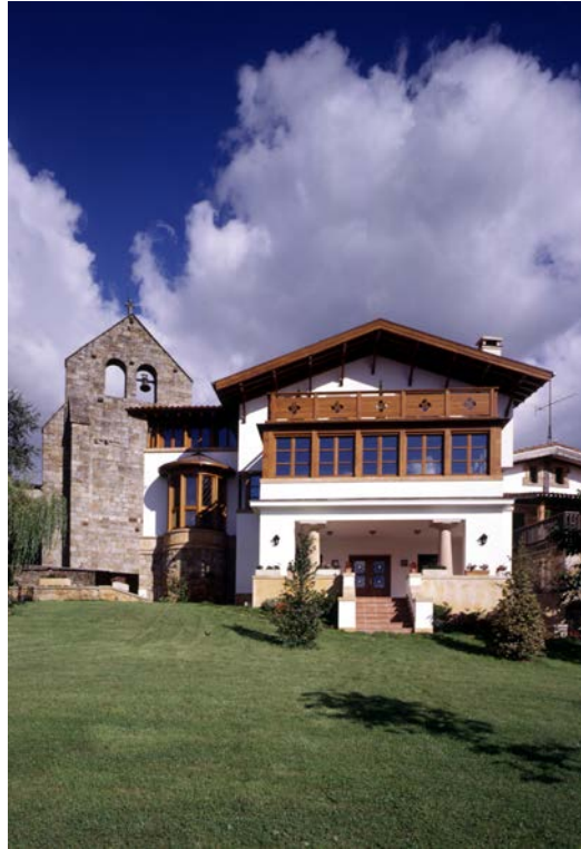
Ampliación de vivienda en Galdácano (Vizcaya), Javier Cenicacelaya e Íñigo Saloña, 1995-1997
