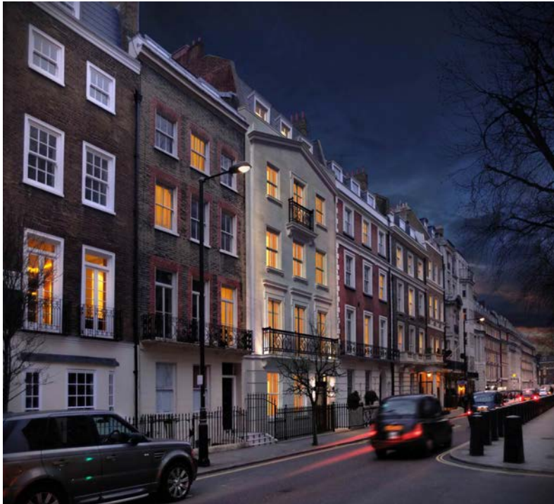
Edificio de apartamentos en Mayfair (Londres), Stanhope Gate Architecture
