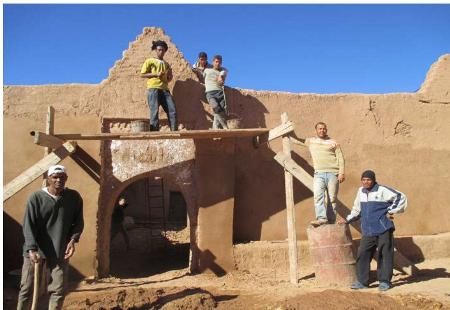
Imagen de las obras de restauración de la puerta del ksar de Ait Aissa Brahim (Zagora, Marruecos), dirigidas por la Asociación Terrachidia en 2013
